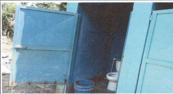
Foto 1: Mantenimiento a estructura (lijado, cambio de tubo, cepillado, sujeciones, aplicación de pintura) a puertas de metal, servicios sanitarios.
